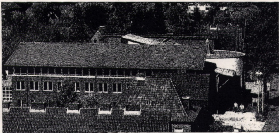
Auch auf dem südlich ausgerichteten Dach des Kronshagener Rathauses kann eine Bürgersolarstromanlage errichtet werden. Die Gemeinde verspricht sich davon eine Signalwirkung für Nischalmer. Foto IV
